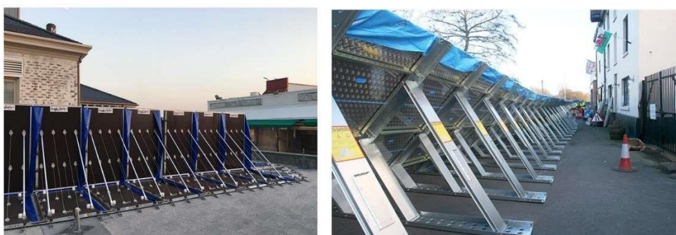
Fig. 29. Exemplificare bariere de protecție temporare. bariere de protecție cu elemente amovibile.
