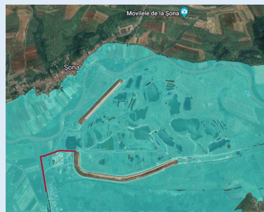
Consolidare mal stang av. ac. Venetia (L mal stang = 1,1 km, h = 3 m)
